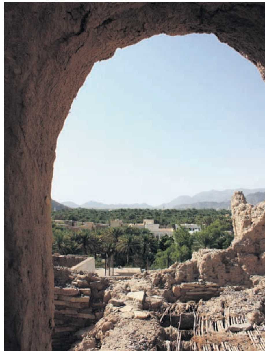
Verlassen: Im Ruinendorf Birkat al-Mus kleben die alten Lehmhäuser noch an den Felsen.
